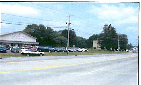
Figure 7-9. Existing conditions in Subarea B.
